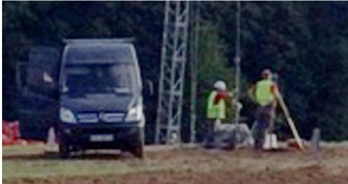
14.09.2015 Windmessmast während des Aufbaus.
